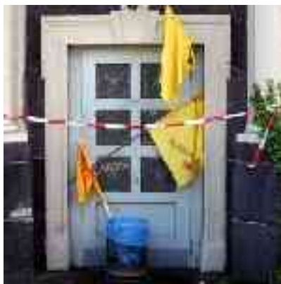
verrammelte Tür am Hauptgebäude
